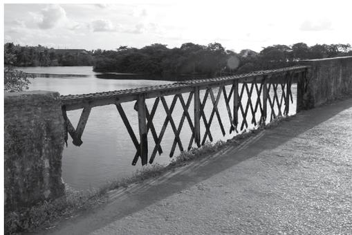
Os travessões na proteção lateral da ponte são visíveis, não há mais ligação das grades de ferro com a base
